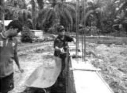
Gambar 3: Warga Ahmadiyah cabang Kunto Darussalam membangun pondasi yang sedianya akan digunakan sebagai bangunan masjid.
