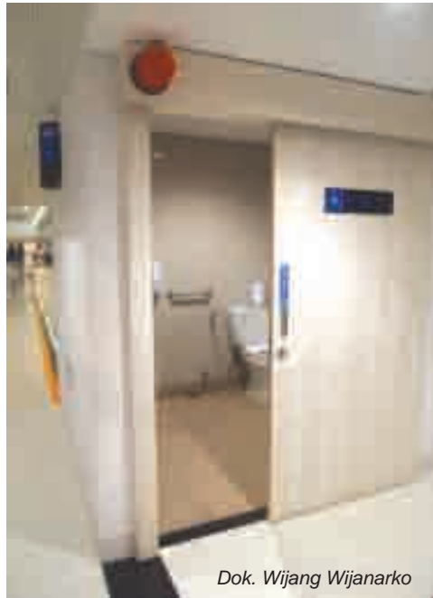
Gambar 7 Pintu Aksesibel menggunakan pintu geser
